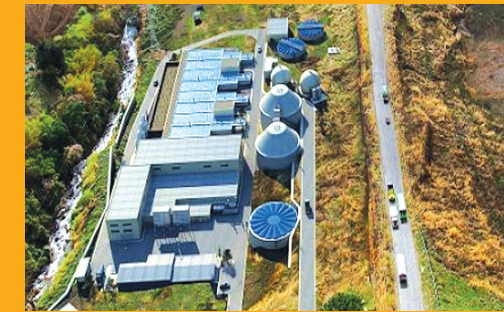
Propuesta de Diseño de la Planta de Tratamiento empresa contratada ACCIONA AGUA SAU.
